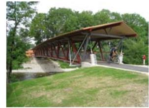
Die Widerlager bestehen aus Stahlbeton, die auf einer Tiefgründung mit Großbohrpfählen stehen, auch wegen der Sicherheit gegen Auskolkung bei Hochwasser.
